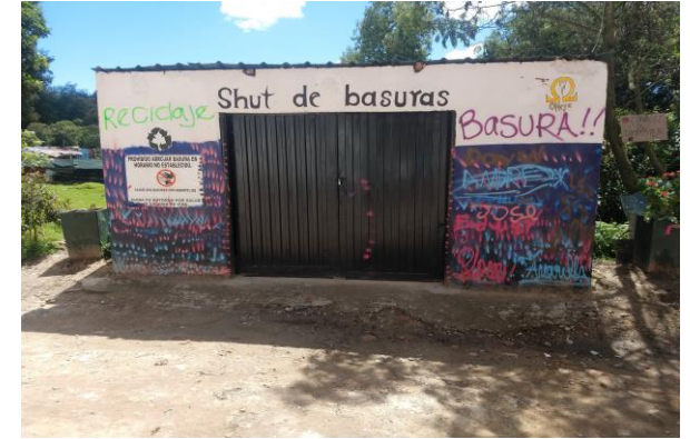
Cuarto de almacenamiento (Después)
